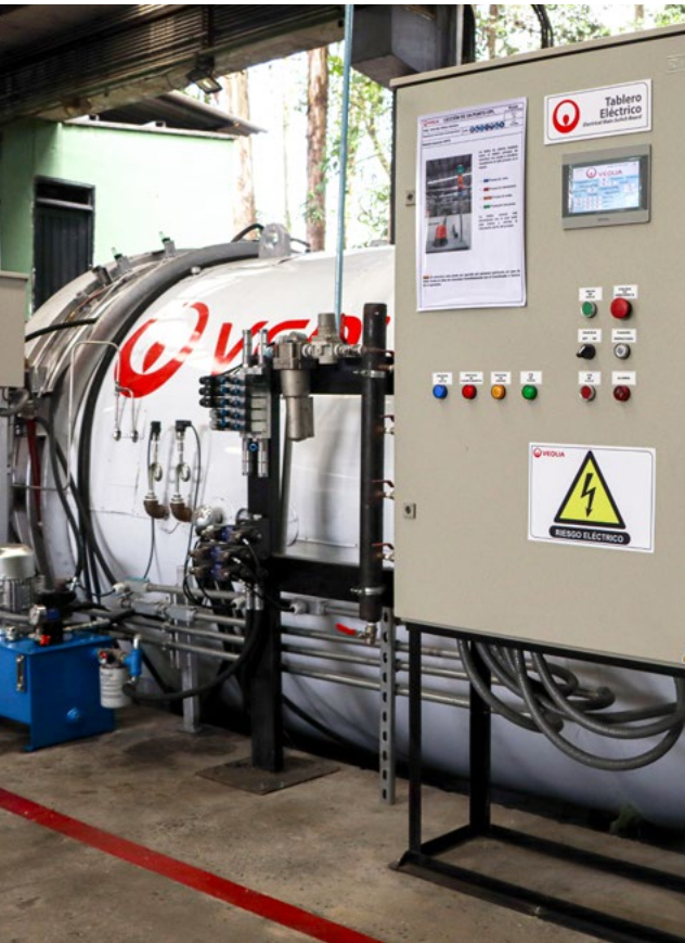
Uso de biogás y gas natural en horno incinerador del CIGE La Esmeralda 2025
